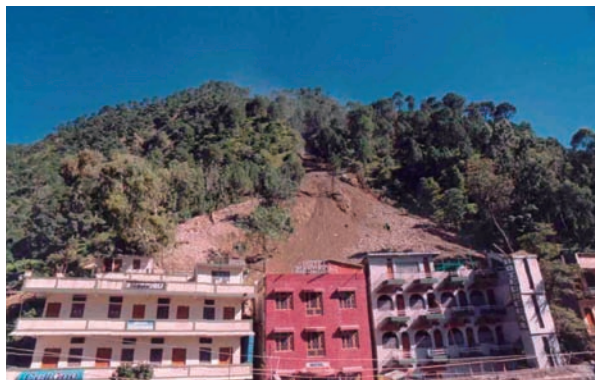
写真1a: ホテルが土砂に埋まる前日の災害現場: 2003年9月25日
