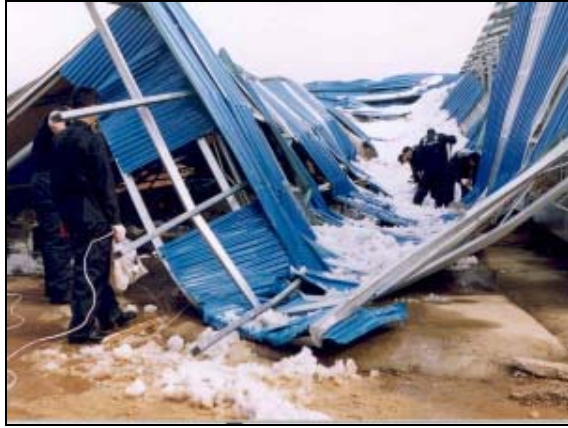
〈2004年の吹雪で損壊した家畜小屋〉
