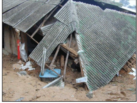
〈2003年の土砂崩れで損壊した家屋〉
