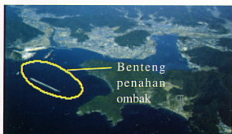
(9) Pembinaan benteng penahan ombak
