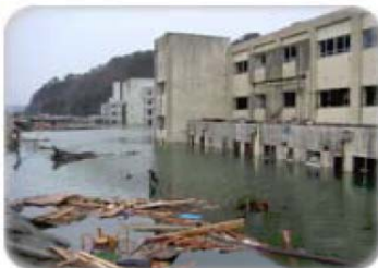
津波によって浸水した隣住居小学校(手前)と釜石東中学校(奥)
