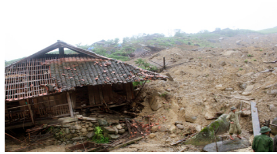
Landslide in Bac Kan in 2009
