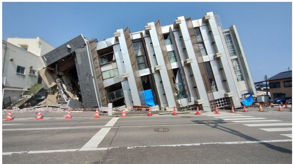
鉄筋コンクリート造7階建てビルの倒壊(輪島市)
