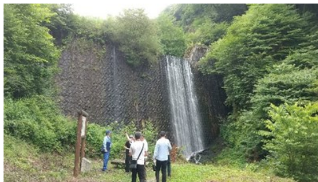
Осмотр противоэрозионных сооружений в бассейне реки Карасу (префектура Гумма)
