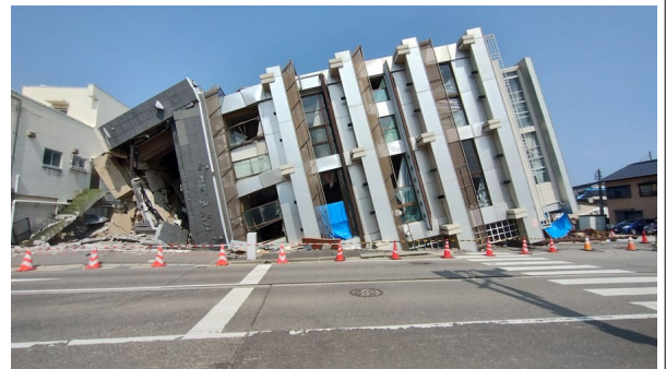
Обрушение 7-этажного железобетонного здания (город Вадзима)
