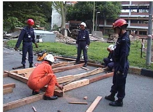
図 4-2-1-2 倒壊ビル搜索時の仮支柱作成訓練
