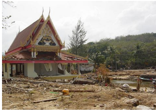
図 6-2-2-1 カマラビーチ（プーケット島）の被害
