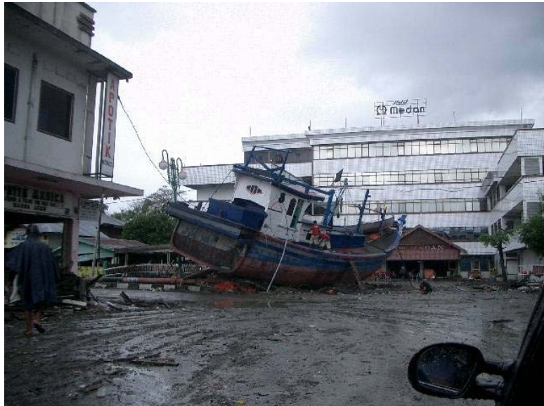
図 6-2-3-2 バンダアチェ市内の津波による被害
